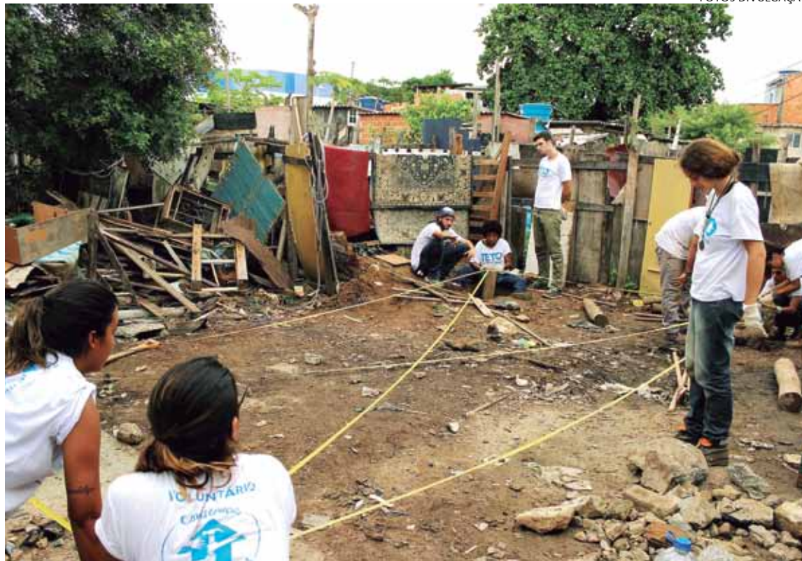
Moradores e voluntários constroem, em um fim de semana, as moradias de emergência feitas de madeira
