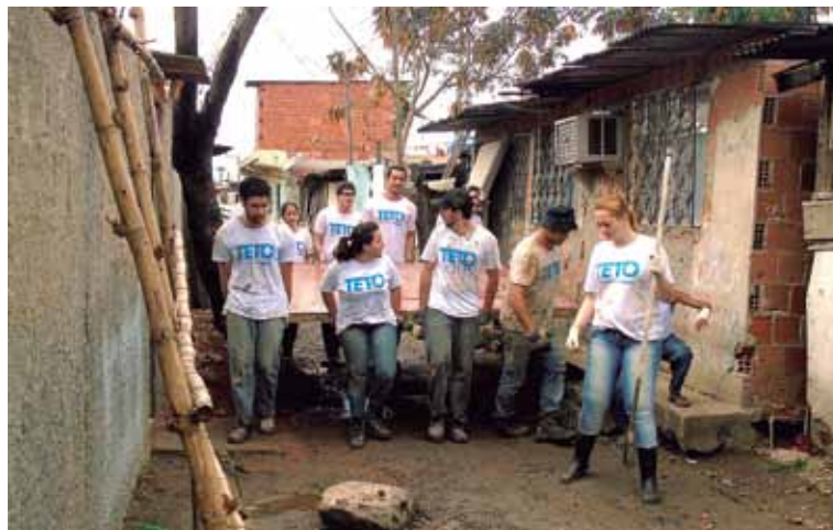
As obras fazem parte do processo de desenvolvimento comunitário
